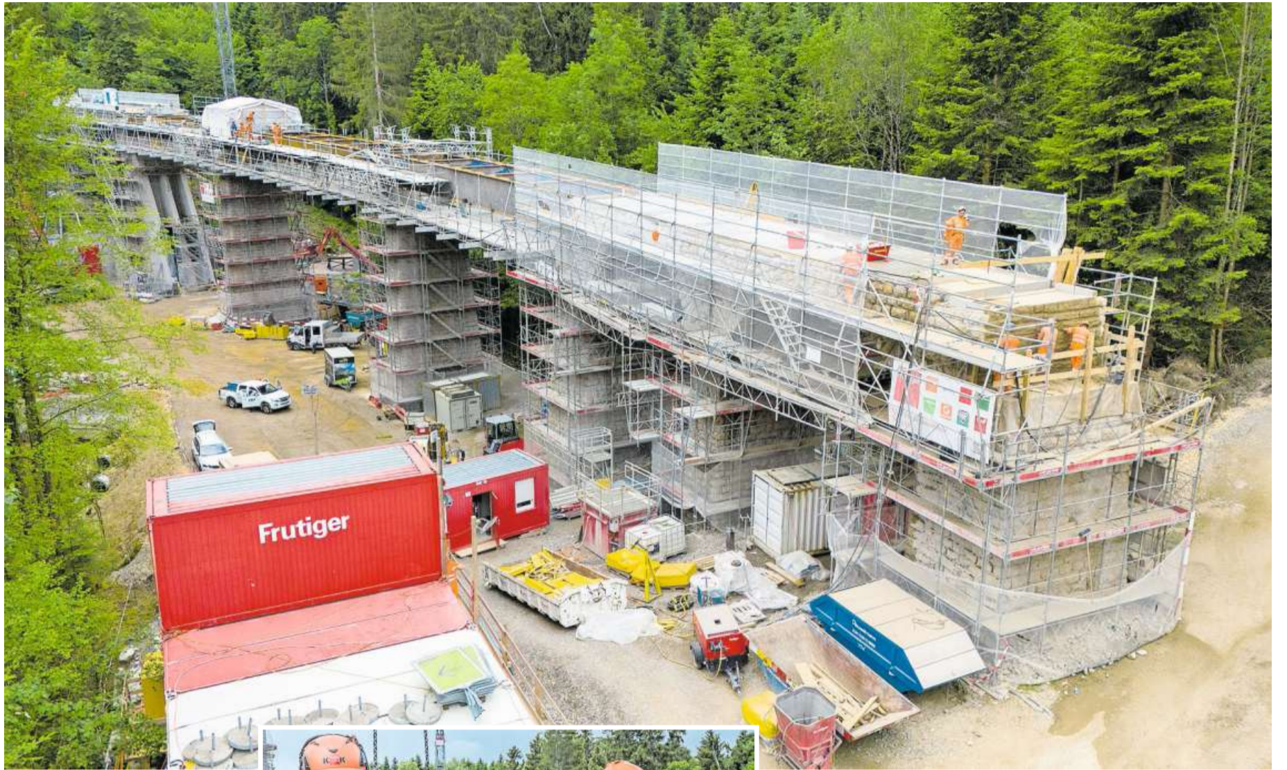
Rund 200 Meter lang ist die Baustelle beim Geisslochviadukt. Bilder: Bruno Kissling
